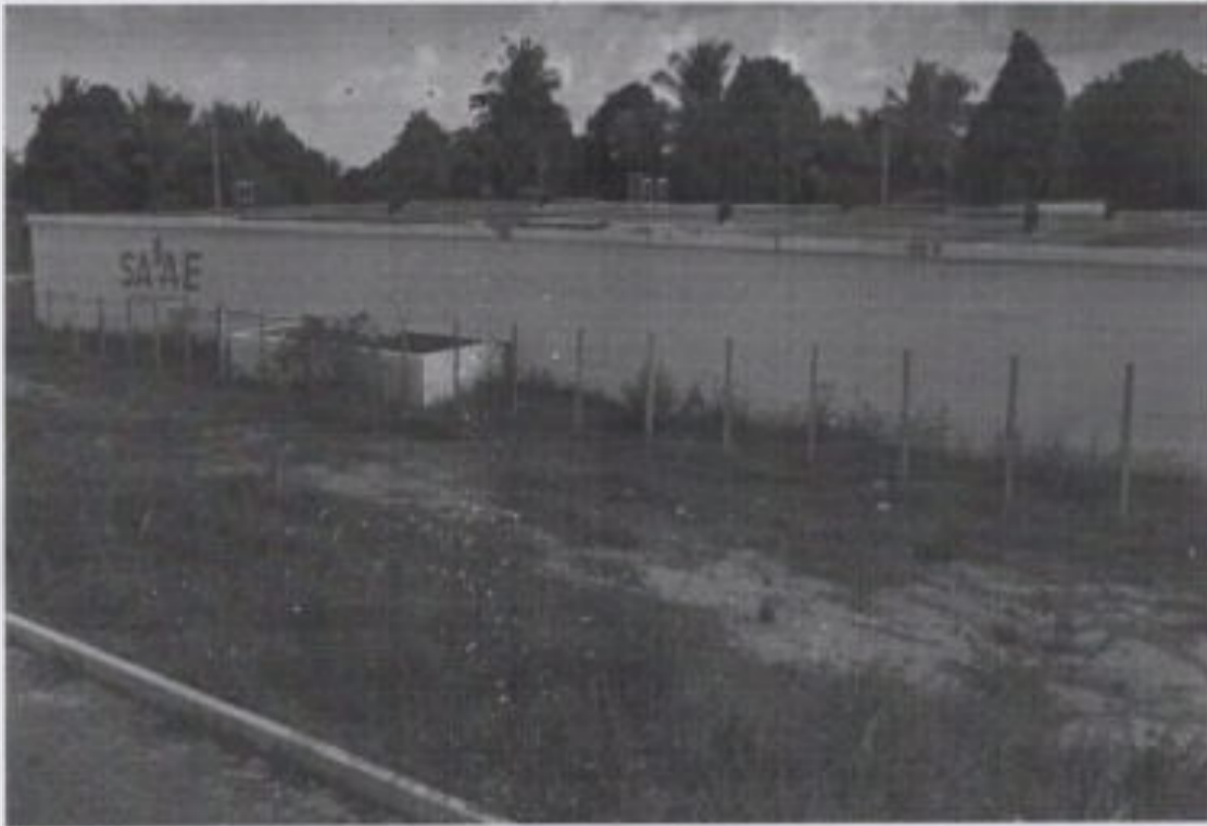
Foto 19- EEAT II - RAP- Reservatório Apoiado.
