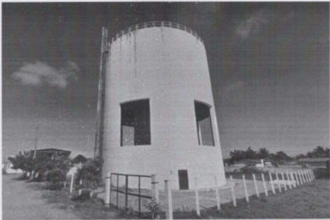
Foto 20 – Reservatório Elevado Jardim Petrópolis.
