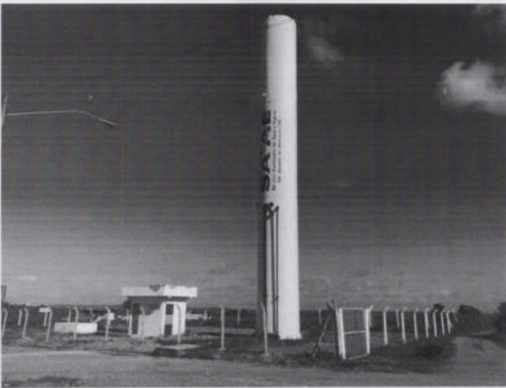
Foto 06 – Reservatório Elevado Cilíndrico Tipo Torre de Aço (Luíza de Queiroz)
