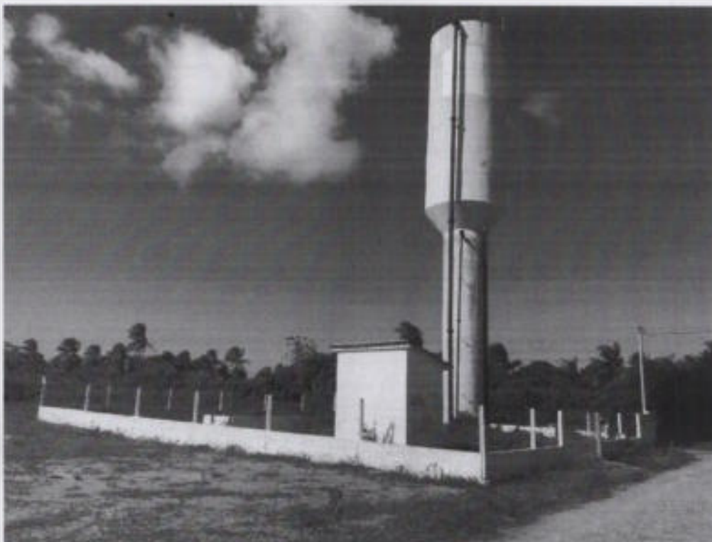
Foto 01 – Reservatório Elevado de Aço Tipo Taça de Coluna Seca (Santos Dummont)
