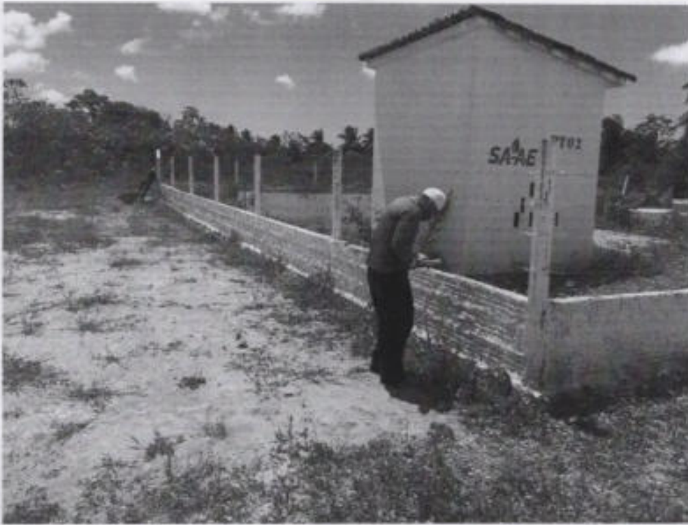
Foto 03 – Vista Lateral (Muro de Contorno + Casa de Comando)
