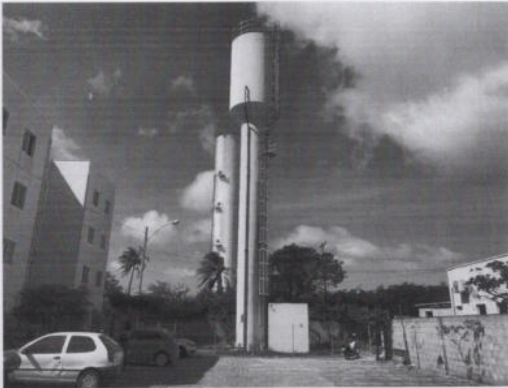
Foto 12 – Reservatório Elevado de Aço Tipo Taça de Coluna Seca N01 – RUA 01
