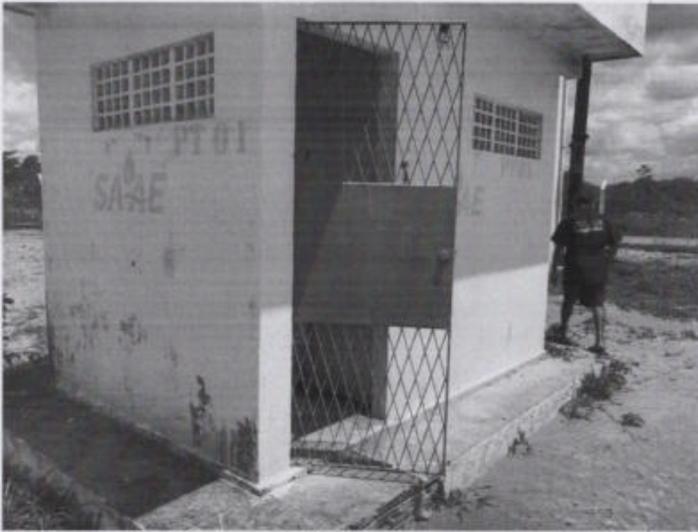
Foto 09 – Portão Metálico da Casa de Comando
