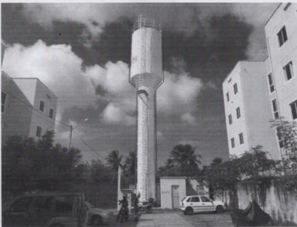
Foto 20 – Reservatório Elevado de Aço Tipo Taça de Coluna Seca N03 – RUA 09
