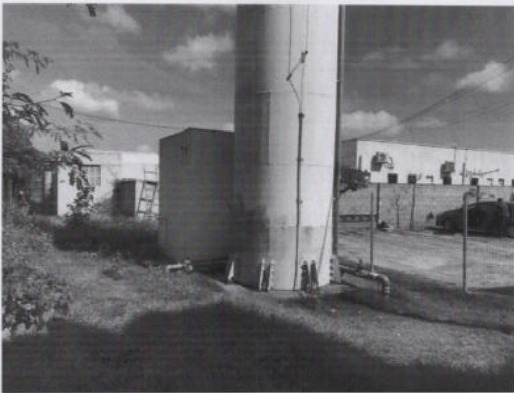
Foto 13 – Vista Lateral + Casa de Comando
