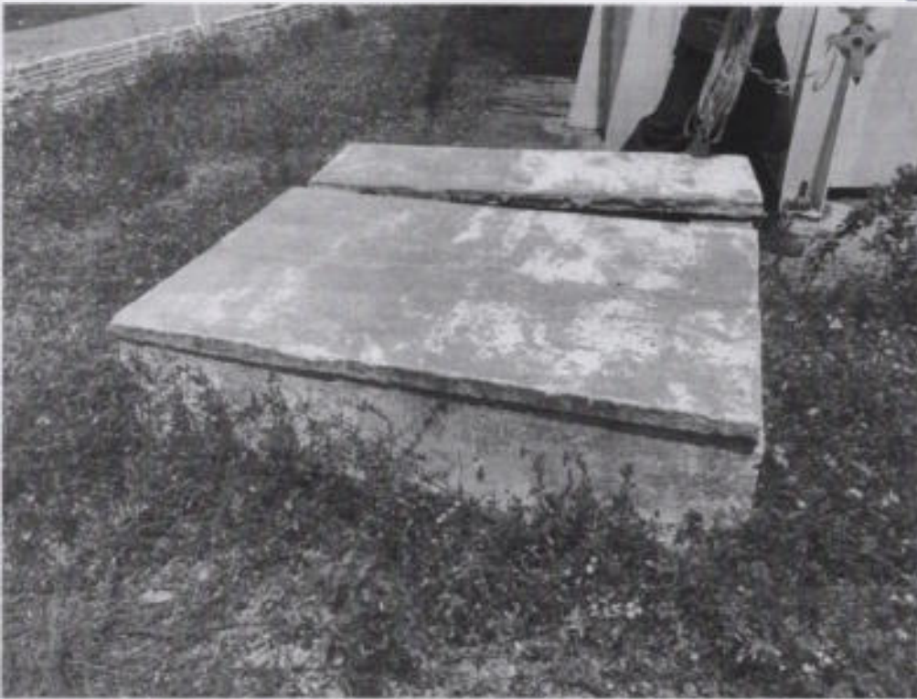
Foto 05 – Casa da Bomba
