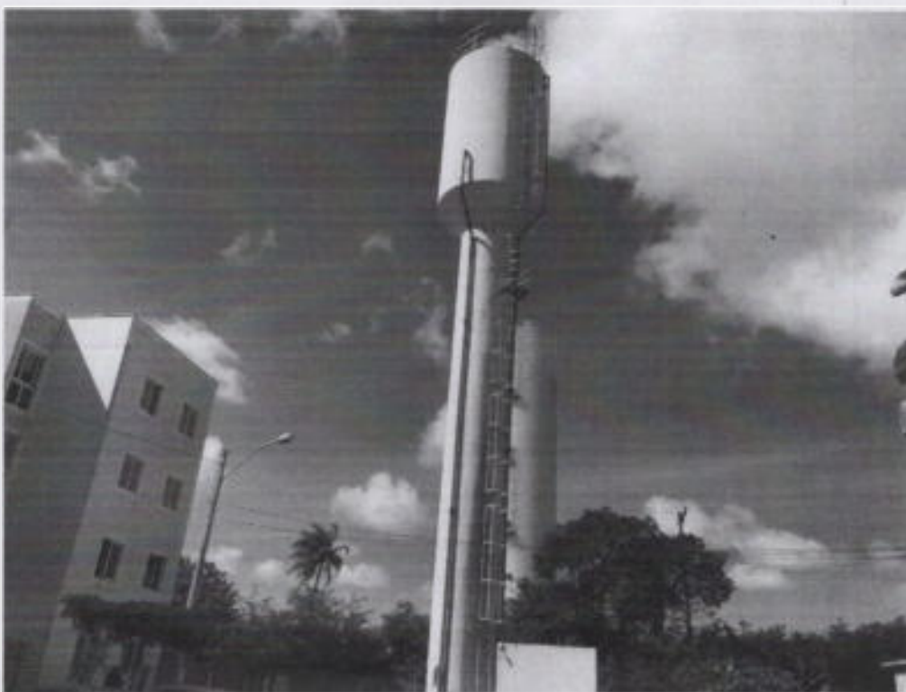
Foto 15 – Vista Frontal + Escada com Guarda Corpo
