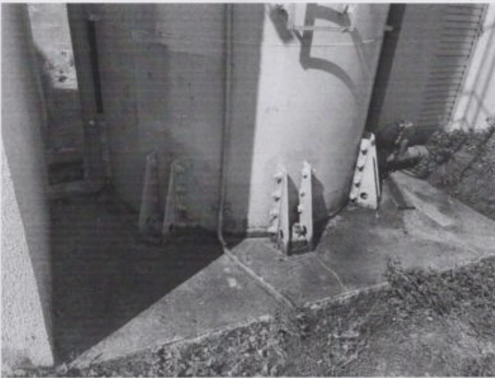
Foto 18 – Pontos de Fixação do Reservatório
