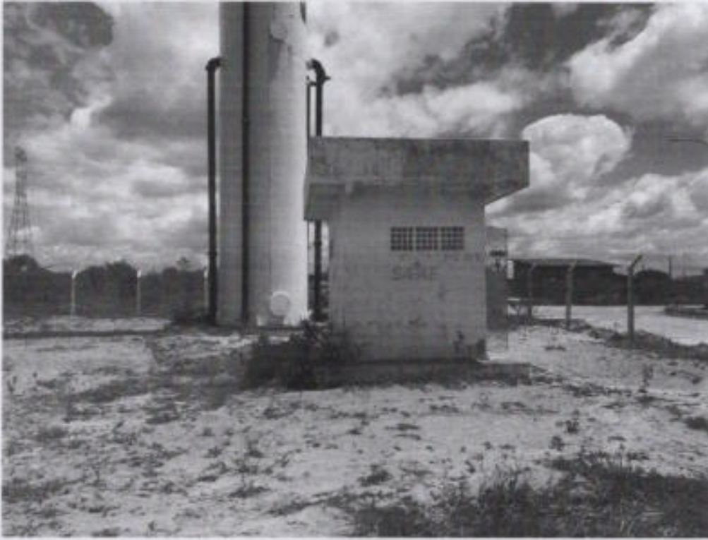
Foto 07 – Vista Lateral (Casa de Comando)
