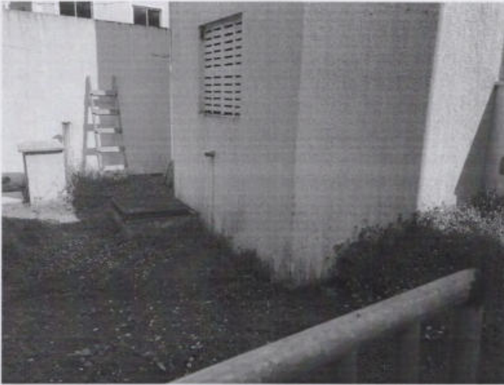
Foto 17 – Casa de Comando
