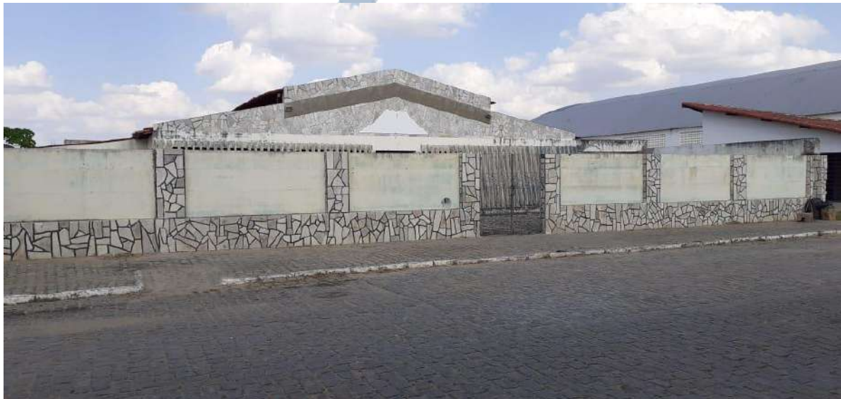
Figura 2 - Foto da fachada frontal existente.
